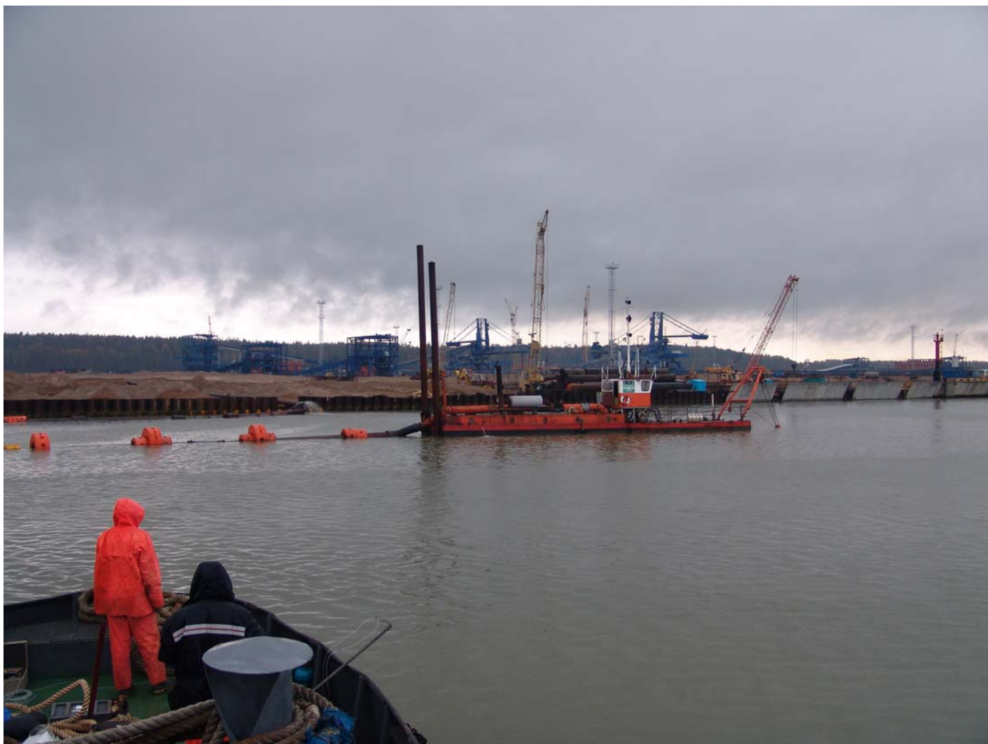
Южная часть Лужской губы в период строительства Паромного комплекса в МТП Усть-Луга (дноуглубление)
